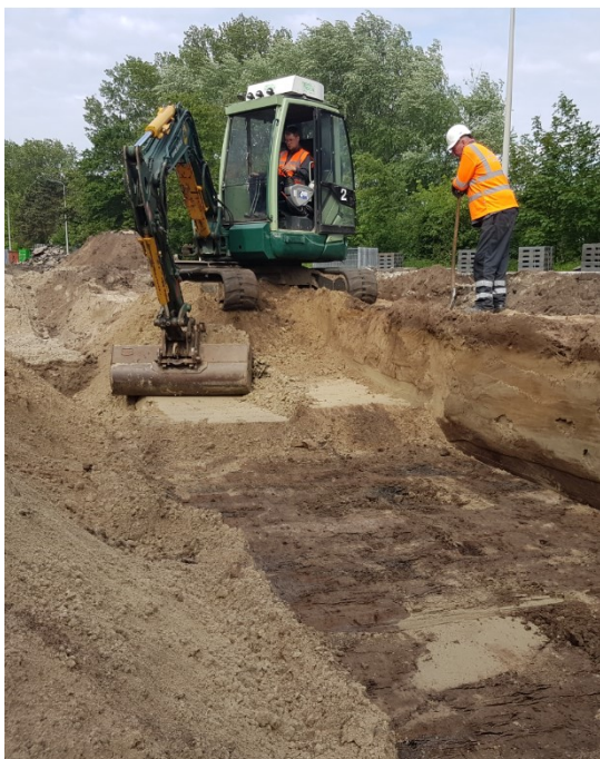
Afbeelding 10, laagsgewijs ontgraven rioolsleuf
