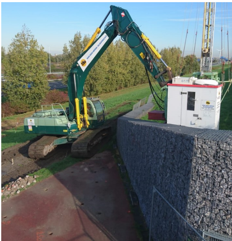
Afbeelding 6, dieptedetectie achter de schanskorf
