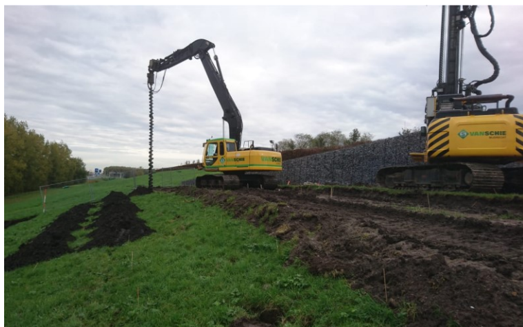
Afbeelding 7, het doorboren van de naoorlogse harde laag
