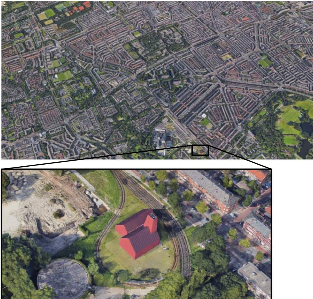
Figuur 4.12 | Locatie Haagse Aardwarmte Leyweg (HAL) ten opzichte van de Vruchtenbuurt in Den Haag. Hemelsbreed ligt de geothermie centrale ongeveer 1.600 m ten zuiden van de Vruchtenbuurt. Het adres van het ketelhuis is Zuidwoldestraat 1 in Den Haag.
