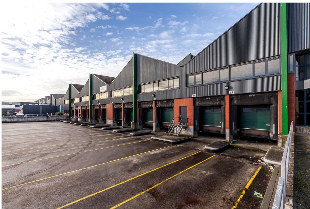
Bedrijfsruimten met loadingdocks, ABC Westland, Poeldijk
